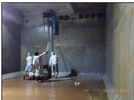
ทำความสะอาดบ่อเก็บน้ำ Fire Water Tank
