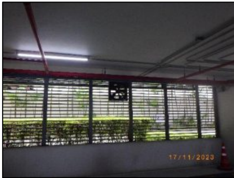
รูปที่ 2-44 พัดลมดูดอากาศภายในอาคารจอดรถ
