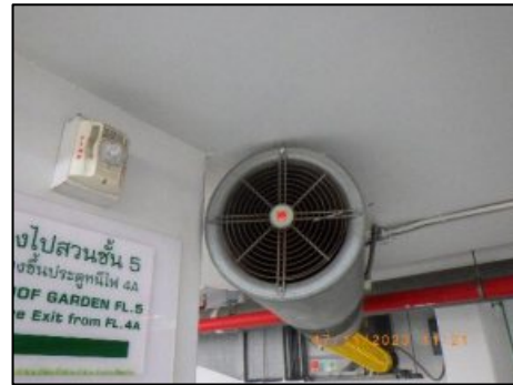
รูปที่ 2-44 พัดลมดูดอากาศภายในอาคารจอดรถ
