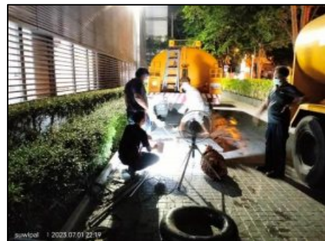
รูปที่ 2-47 การสูบล้างท่อและตะกอนส่วนเกิน
