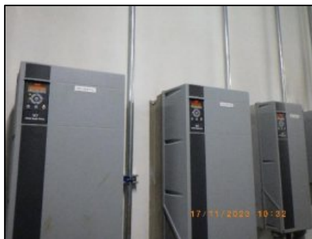
รูปที่ 2-27 อุปกรณ์ปรับรอบความเร็วมอเตอร์ VSD
