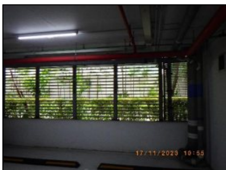
รูปที่ 2-43 ช่องเปิดโล่งถ่ายเทอากาศ
