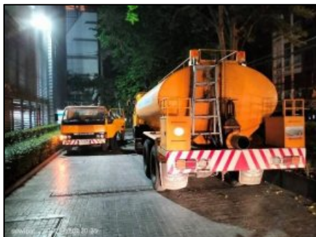
รูปที่ 2-47 การสูบล้างท่อและตะกอนส่วนเกิน
