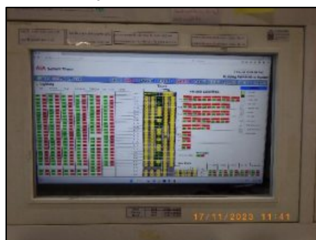
รูปที่ 2-24 การติดตั้งเครื่องปรับระดับแสงสว่าง (Dimmer) และควบคุมผ่านหน้าจอคอมพิวเตอร์
