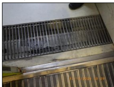
รูปที่ 2-18 ท่อรวบรวมน้ำจากการล้างห้องพักมูลฝอย
